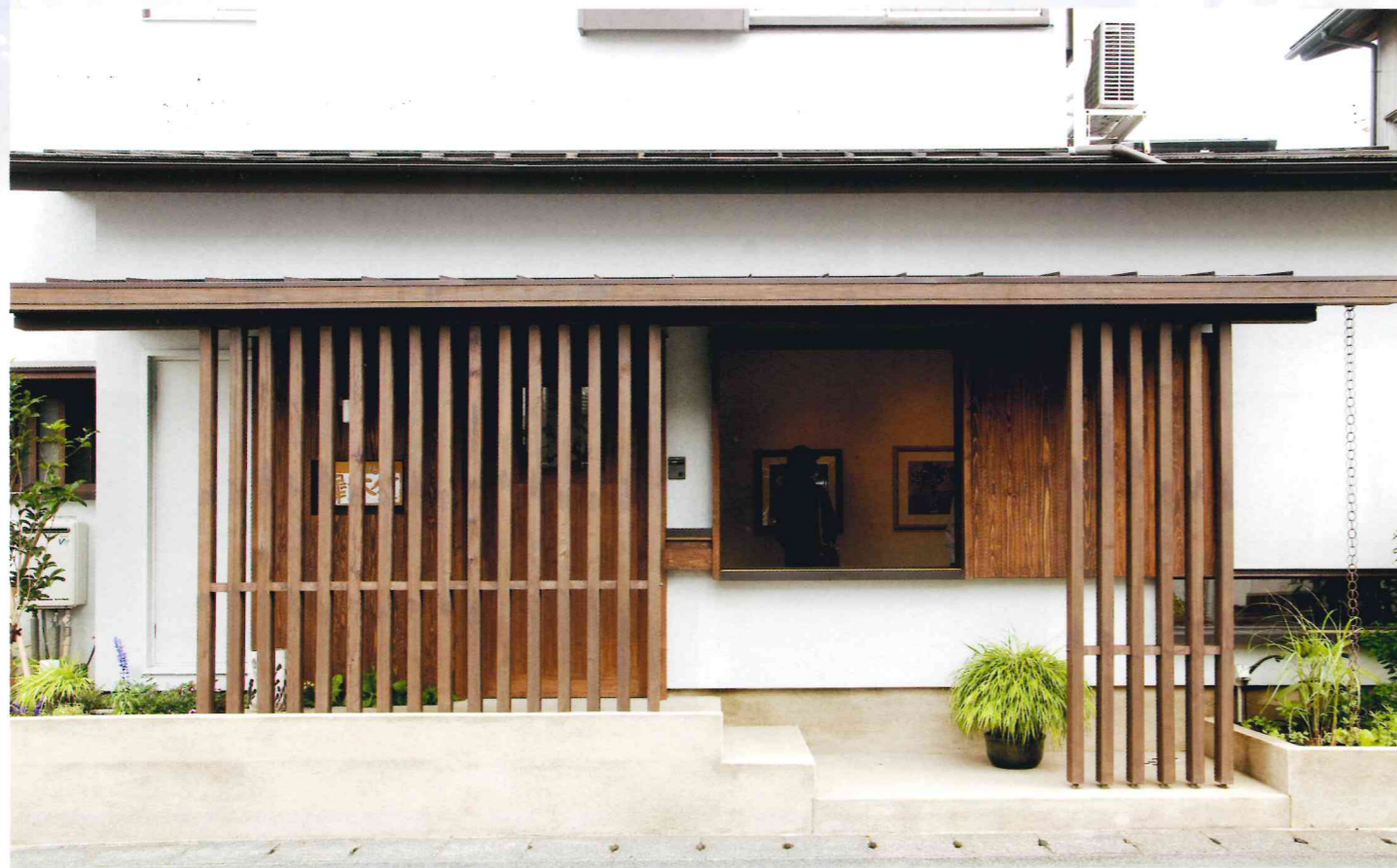
北側外観。ギャラリーの入口兼自宅玄関。少しゆっくりアプローチしています。
