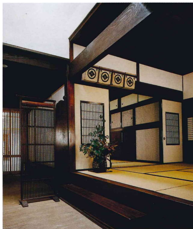
▲玄関から土間ざしに、みせのま、なかのま、おかってをみる 改修による大きな変更はない。補修は腐った土台の取り替え、構造補強、建具の繕い、壁の漆喰塗り、土間床のモルタル塗りなど。
